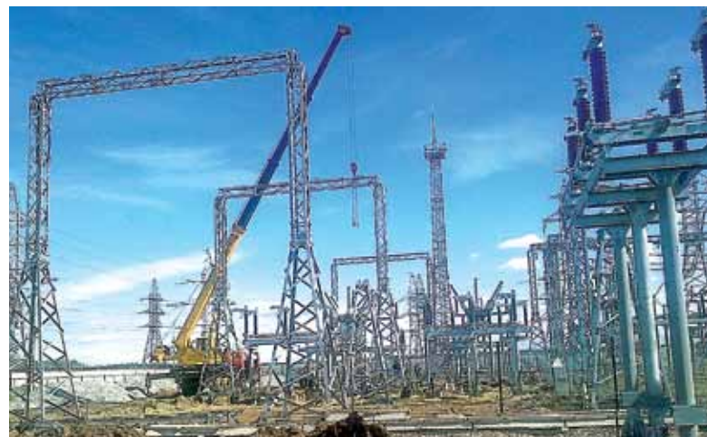
Установка компенсирующего устройства на ПС 220КВ Соболи
