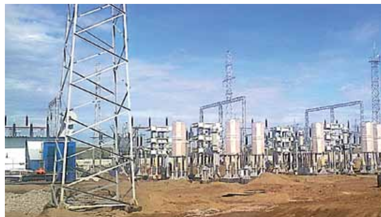
Установка компенсирующего устройства на ПС 220КВ Соболи
