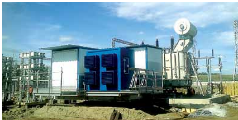
Установка компенсирующего устройства на ПС 220КВ Соболи
